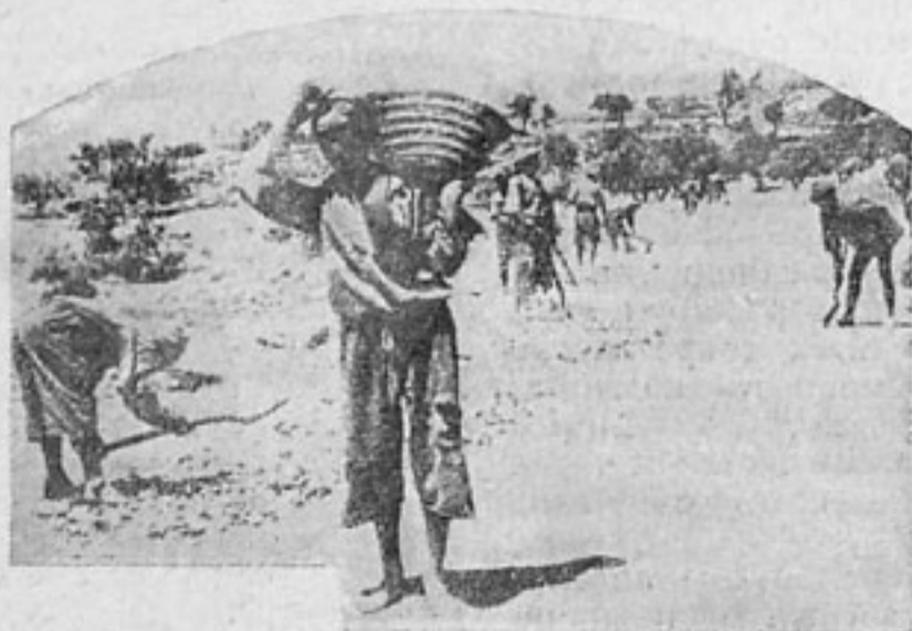
Дорожные работы в Палестине.
